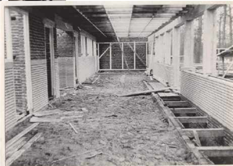
MAVO school in aanbouw 1950, hier de latere Blauwe gang en deur midden links het keukentje van Anny Frenken
