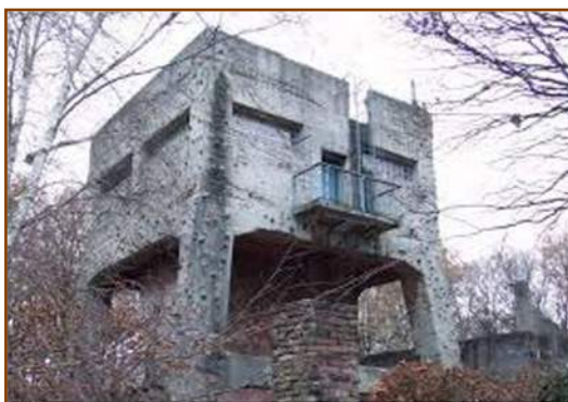
De verkeerstoren, nu in gebruik als klintoren
